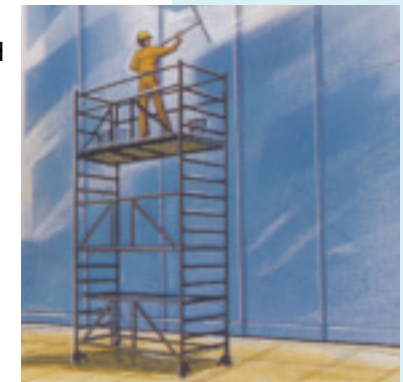
Gerüst mit Aufstiegsleiter
