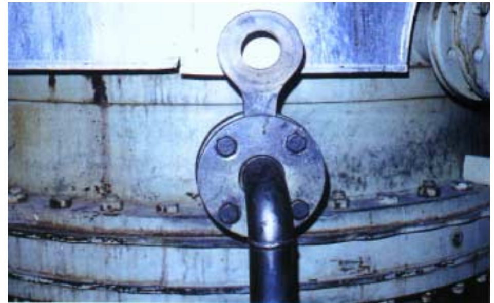
Großer Leitungsquerschnitt: Absperrung durch Steckscheibe möglich
