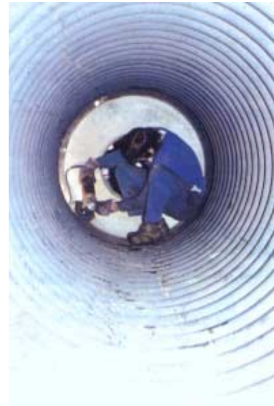
Schleifarbeiten in einem begrenzten, leitfähigen Raum
